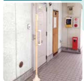
手すりの基本は進行方向で支持できる事です。段差の昇降、立ち上がりなど壁にどうわざずに設置できます。
